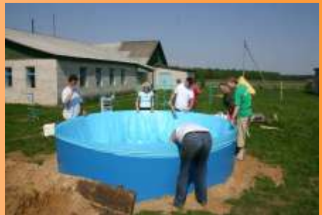
Bassin für Kindergarten in Koselje 2005
