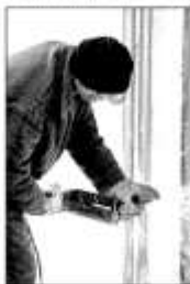
Trennschleifeneinsatz: Michael immer rückt am Samstag alten Heizungsrohren zu Leibe.
